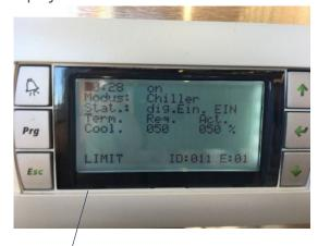
Bei reduzierter Leistung über Schalter oder Fehlen der Brücke erscheint Limit blinkend auf dem Display.
